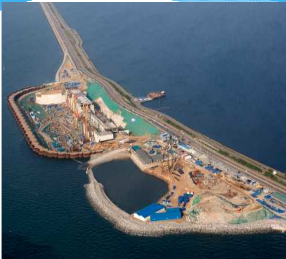
Sihwa Tidal Power Plant , pogled iz zraka www.advancedtechnologykorea.com
