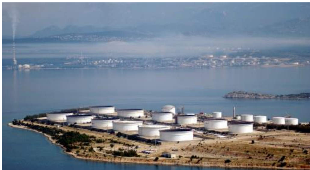
Slika 44: Trenutni izgled LNG Omišalj na Otoku Krk
