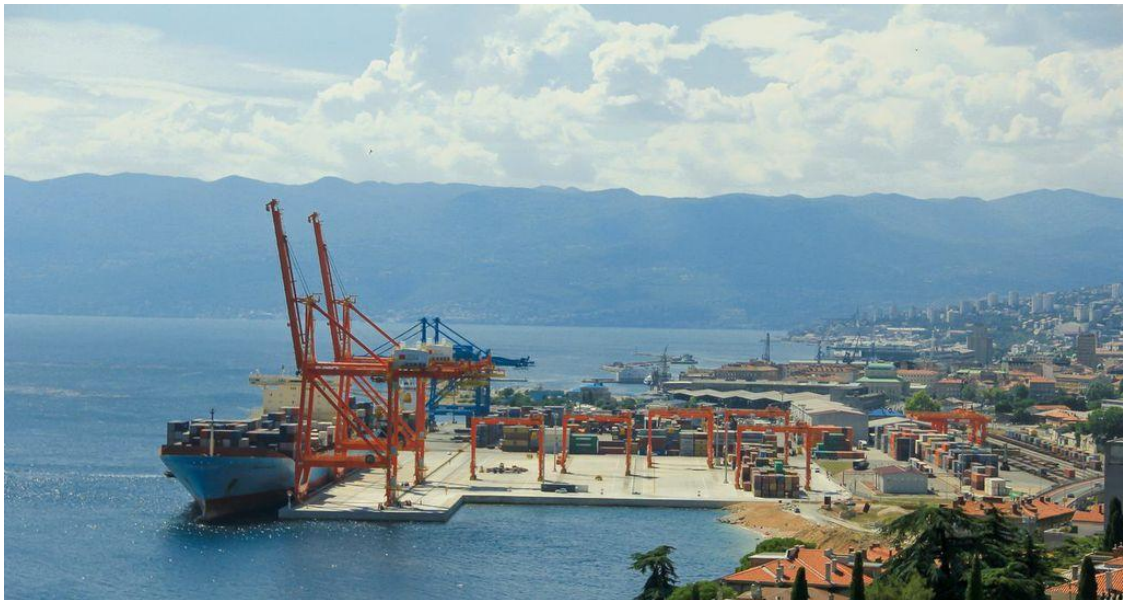
Slika 2.2 - Kontejnerski terminal Jadranska vrata (Adriatic Gate Container Terminal)
