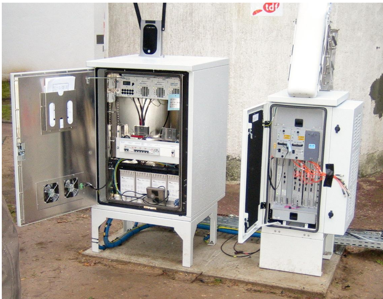
Slika 11. WiMAX bazna stanica sa sektorskom antenom i modemom
