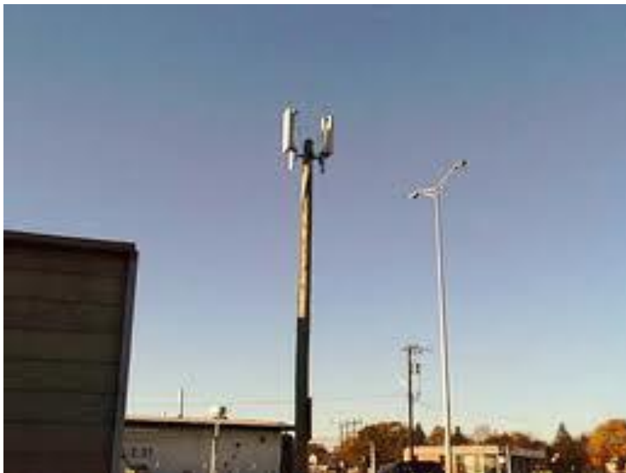
Slika 19. Antene s mikro ćelijama koje pokrivaju područje oko 2 km
