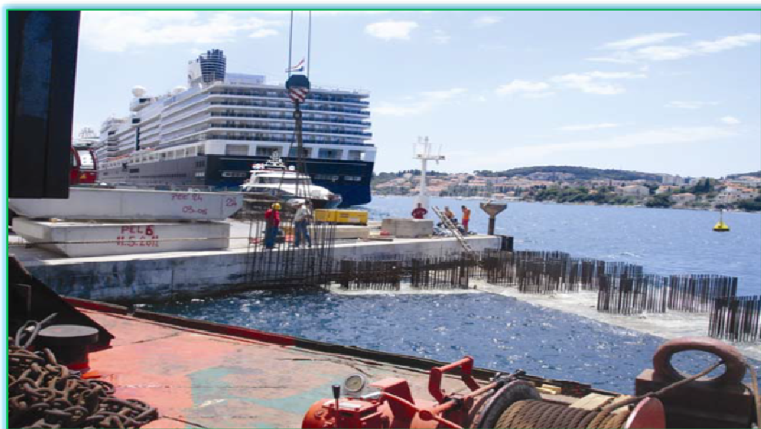
Slika 20. Izvedba zidova produženja vezova 16. i 17 Izvor: www.casopis-gradjevinar.hr , 5.7.2013.
