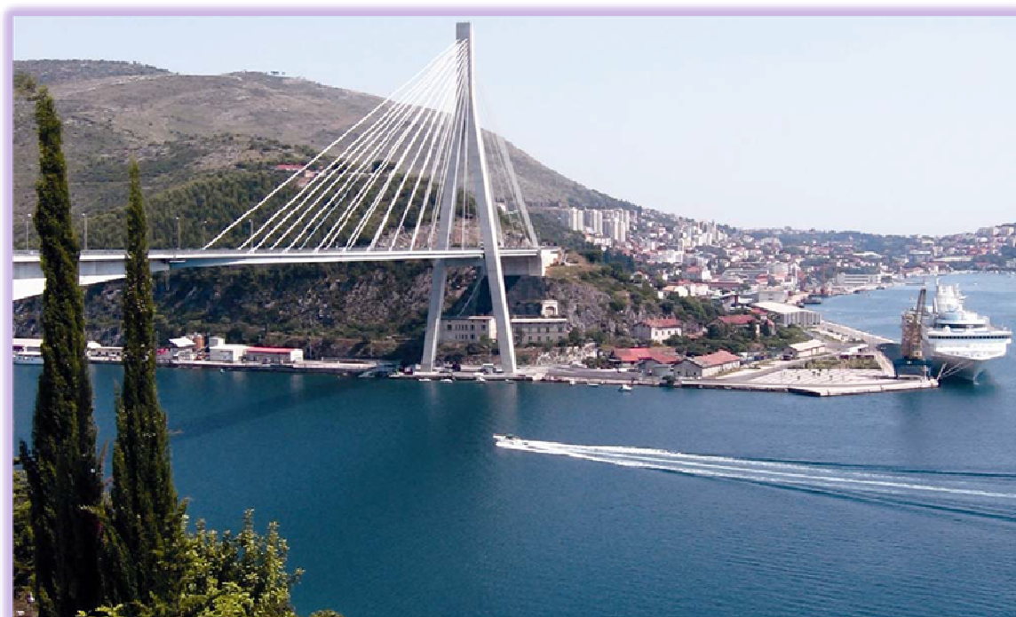
Slika 18. Mjesto gdje se gradi Batahovina I – Dubrovački most (Most Franje Tuđmana) i ulaz u luku Gruž, Izvor: www.casopis-gradjevinar.hr , 5.7.2013.
