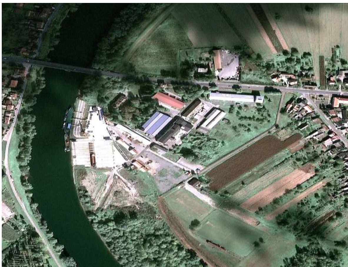
Slika 3: Ortofoto snimak na brodogradilišno pristanište Galdovo, (Izvor: Lučka uprava Sisak)
