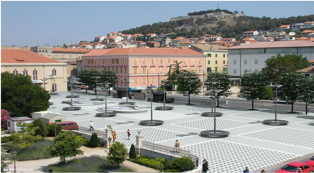
Slika 25. Poljana nakon izgradnje podzemne garaže
