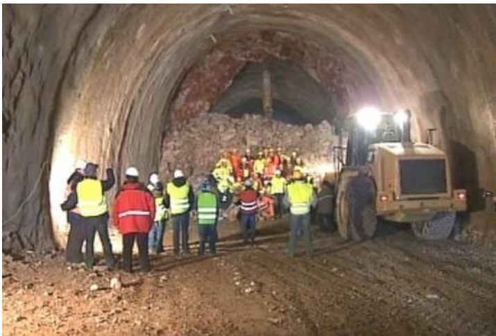
Slika 2: Probijen posljednji tunel na dionici Rijeka - Zagreb
