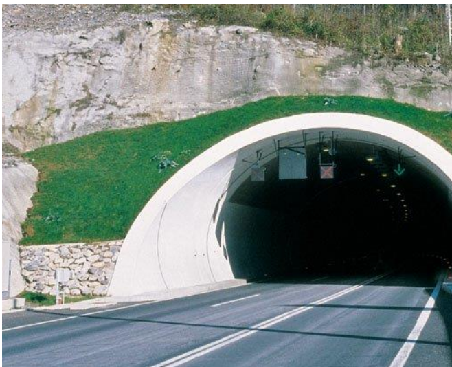
Slika 3: Tunel Veliki gložac
