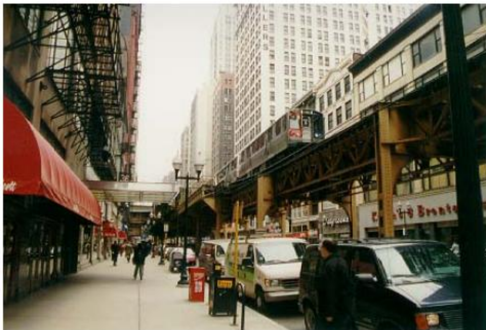
Slika 17. Tračnički sustav na vijaduktu (Chicago) Izvor: http://www.fpz.unizg.hr/ztos (kolovoz, 2013.)
