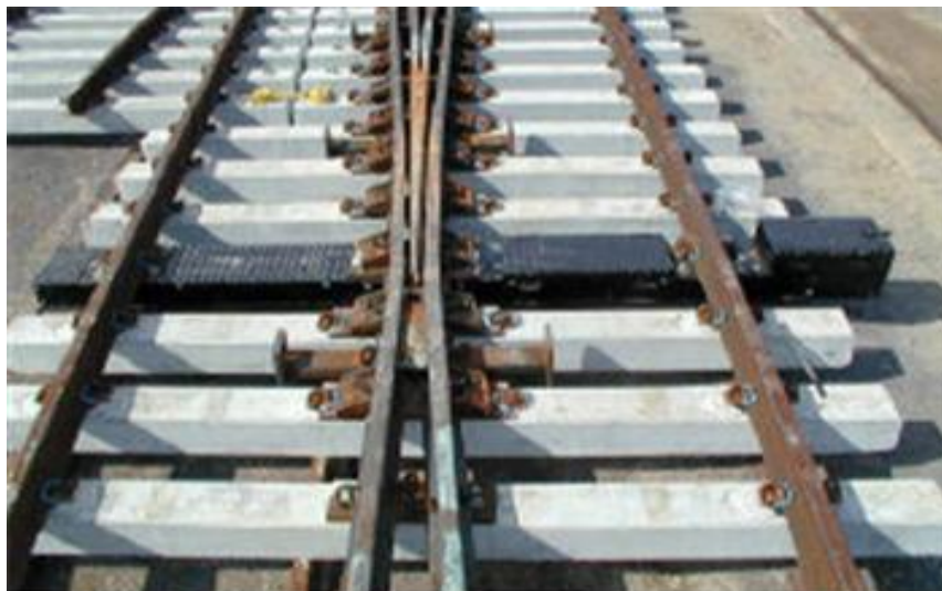
Slika 8. Pokretno središte skretnice
