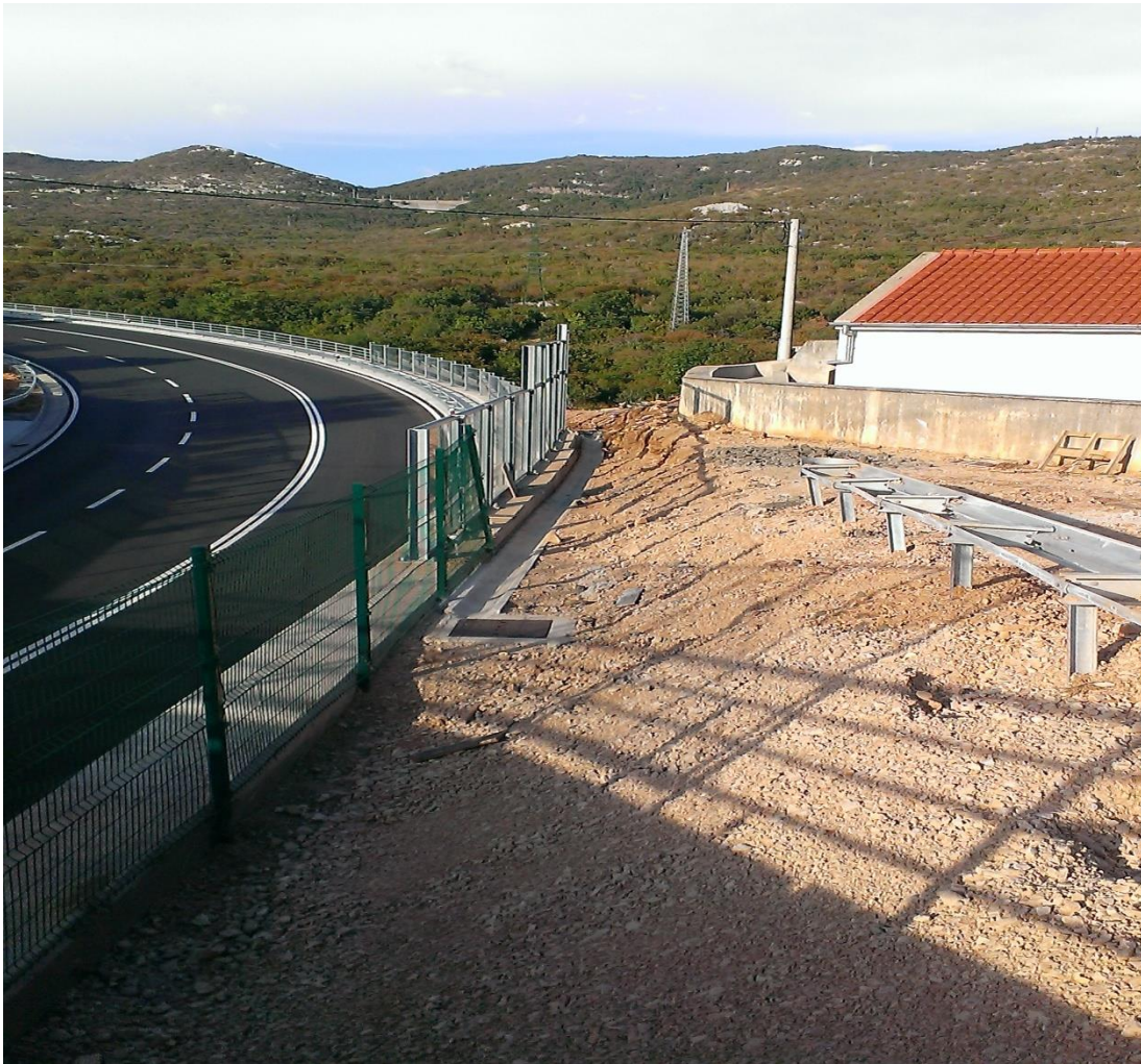
Slika 31. Sanirani dio za oborinsku vodu na čvoru Hreljin
