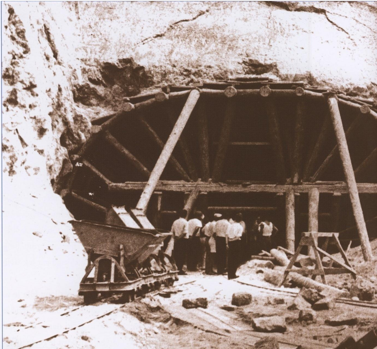
Slika 24. Izgradnja tunela u Donjoj Dobri
