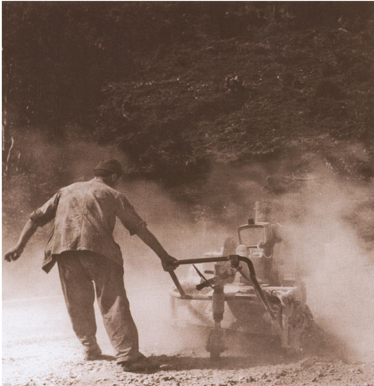
Slika 23. Priprema podloge za asfaltiranje, Nova Lujzijana
