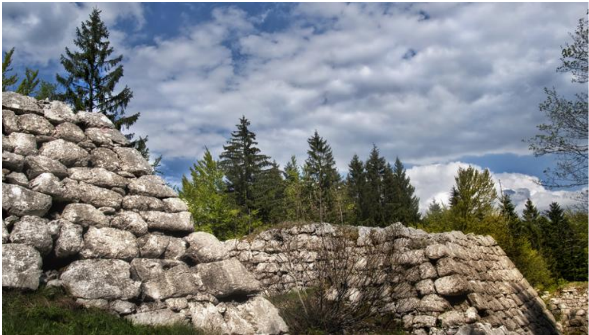
Slika 33. Kameni "fajeri" na kojima su počivali drveni vijadukti u Brestovoj Dragi
