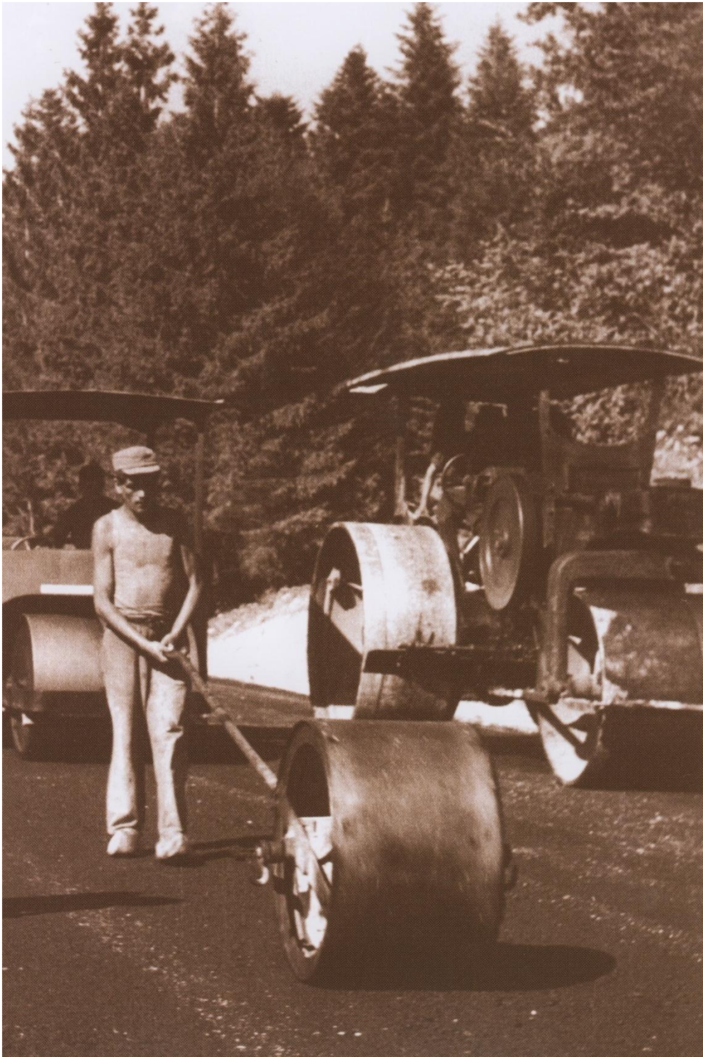
Slika 29. Valjci izrađeni u domaćoj proizvodnji, zagrebačka "Mehanizacija"
