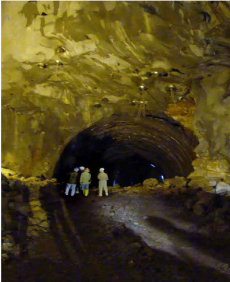
Slika 5. Kaverna u tunelu Vrata
